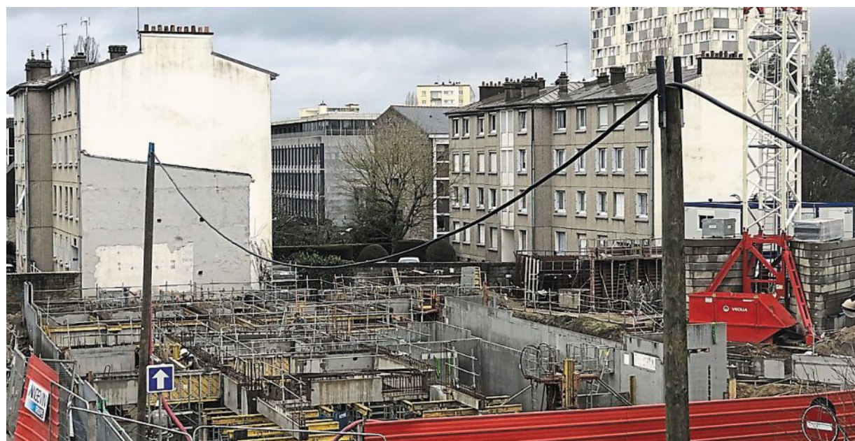
De nombreux chantiers sont en cours dans le centre-ville de Vannes, comme ici Avant-scène, un projet de Lamotte Immobilier, à l'angle des rues du Moulin et du 8-Mai-1945.
